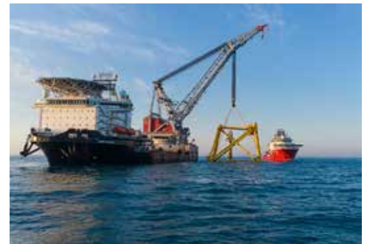
Caisson installasjon, Yme-feltet. Kunde: Repsol.
