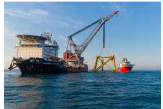
Caisson installasjon, Yme-feltet. Kunde: Repsol.
