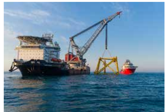
Caisson installasjon, Yme-feltet. Kunde: Repsol.
