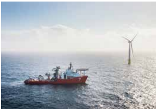
Hywind Tampen. Oppkobling til Snorre A. Kunde: Subsea7.
