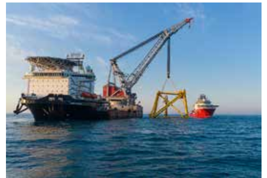
Caisson installasjon, Yme-feltet. Kunde: Repsol.
