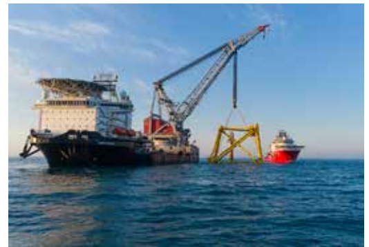
Caisson installasjon, Yme-feltet. Kunde: Repsol.
